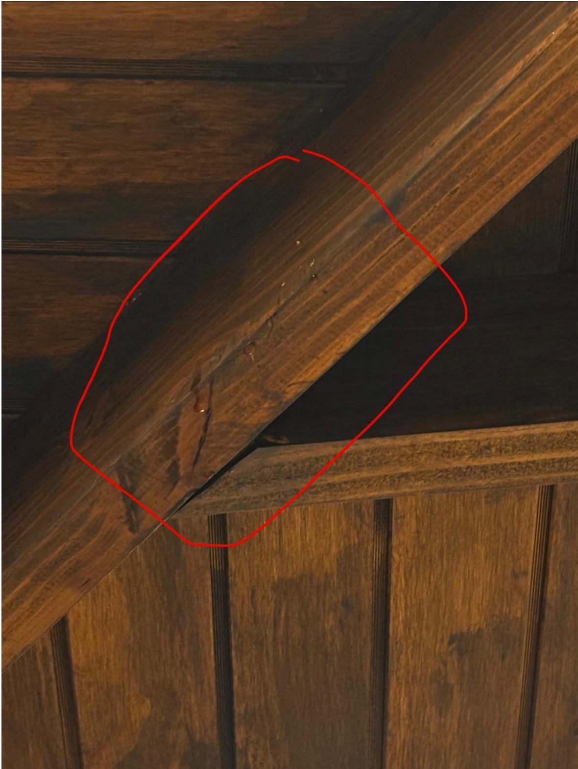
TECHO TERRAZA CASA 1
